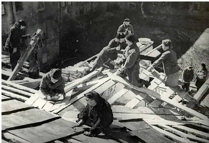
Рис. 2. Бойцы МПВО Октябрьского района восстанавливают крышу дома
